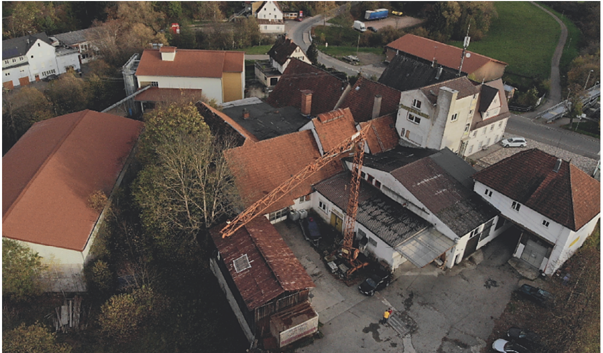
Abb. 3: Gebäudekomplex der ehemaligen Rosenbrauerei, Schrägaufnahme von Nordwesten.
