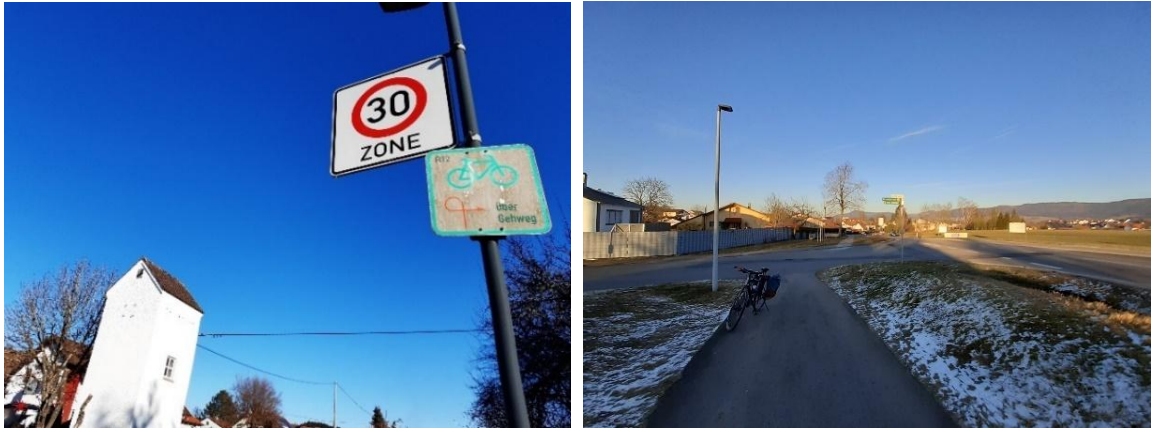
Abbildung 40: Fahrradaltwegweiser, fehlende gesicherte Überleitung zwischen Radverkehrsführung innerorts (Fahrbahn) und außerorts (Radweg)
