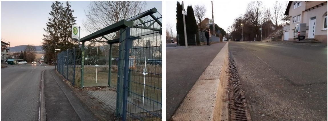
Abbildung 36: Zumeist kein barrierefreier Ausbau der Bushaltestellen, barrierefreie Bushaltestelle am Bahnhof Aldingen
