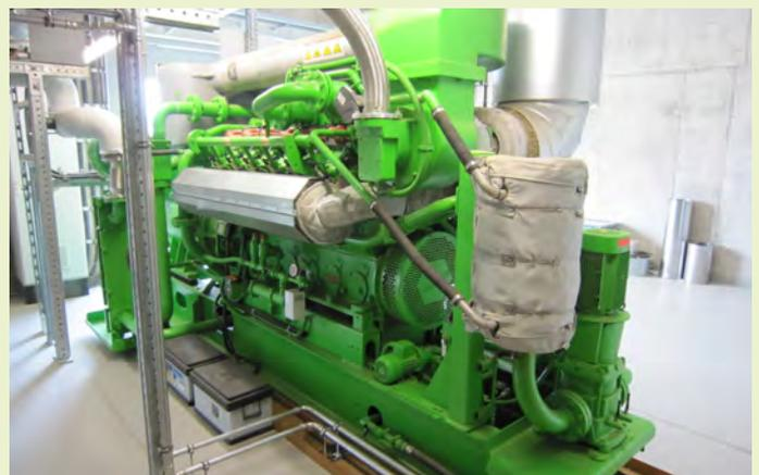
Abb. 2: Biomethan-Blockheizkraftwerk in der Nahwärmezentrale, Aldingen
