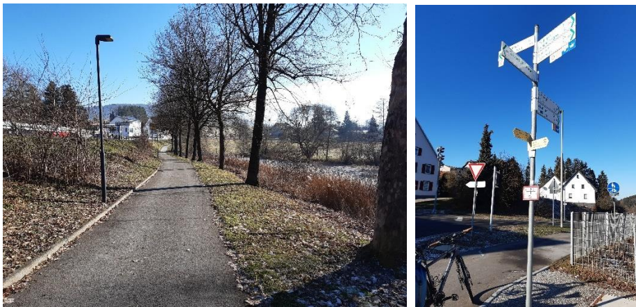
Abbildung 36: Radweg an der B14 (Radnetz BW) mit Beleuchtung, Fahrradwegweisung
