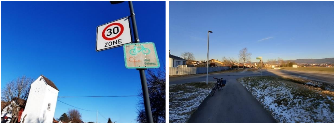
Abbildung 39: Fahrradwegweiser, fehlende gesicherte Überleitung zwischen Radverkehrsführung innerorts (Fahrbahn) und außerorts (Radweg)
