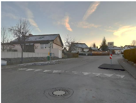
Abbildung 33: Fahrbahneinengungen bei der Einfahrt in Tempo-30-Zonen
