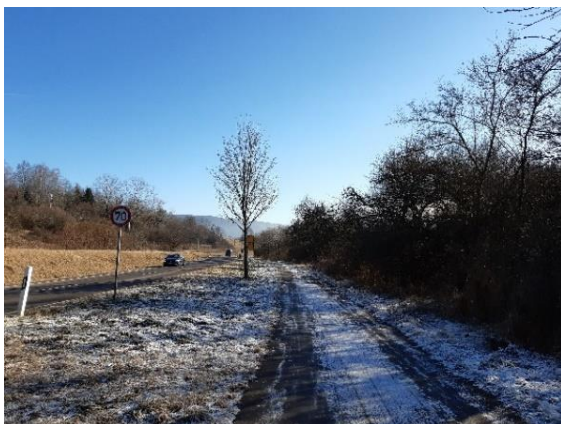
Abbildung 38: Radweg B14, kein Winterdienst und streckenweise Fahrbahnschäden, stark unterdimensionierte Radverkehrsanlage Trossinger Straße (L433) / Zotterangen
