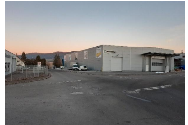
überdimensionierte Knotenpunktgestaltung z. B. Hölderlinstraße / Steigstraße
