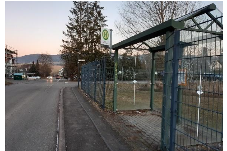
Zumeist kein barrierefreier Ausbau der Bushaltestellen
