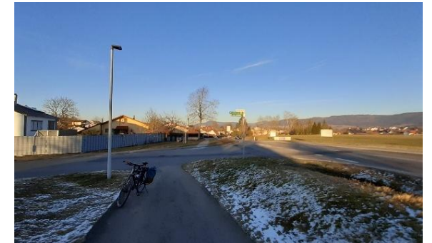
Fahrradaltwegweiser fehlende Überleitung zwischen Führung innerorts und außerorts
