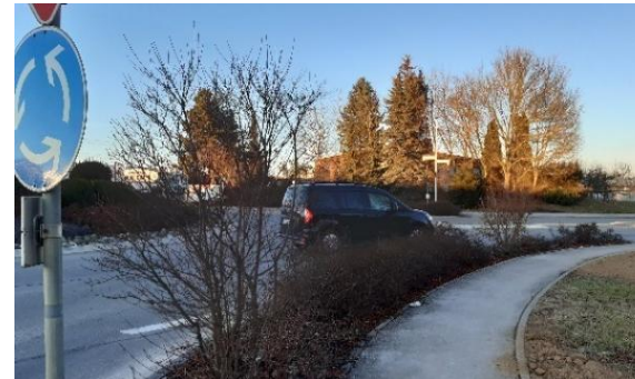
RW B14, kein Winterdienst und streckenweise Fahrbahnschäden stark unterdimensionierte RVA Trossinger Straße (L433) / Zotterangen
