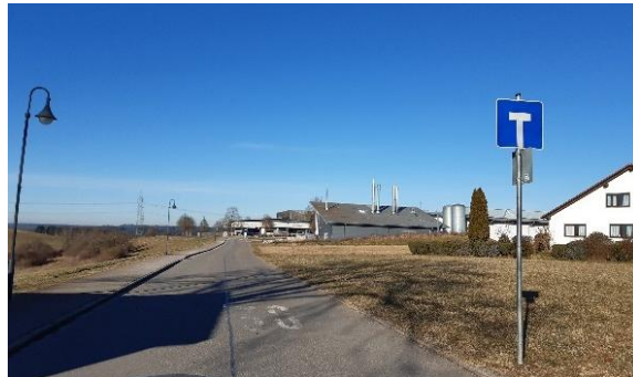
Fahrradabstellanlagen mit Vorderradklemmen am Hallenbad keine durchlässige Sackgasse für Fuß- und Radverkehr beschildert
